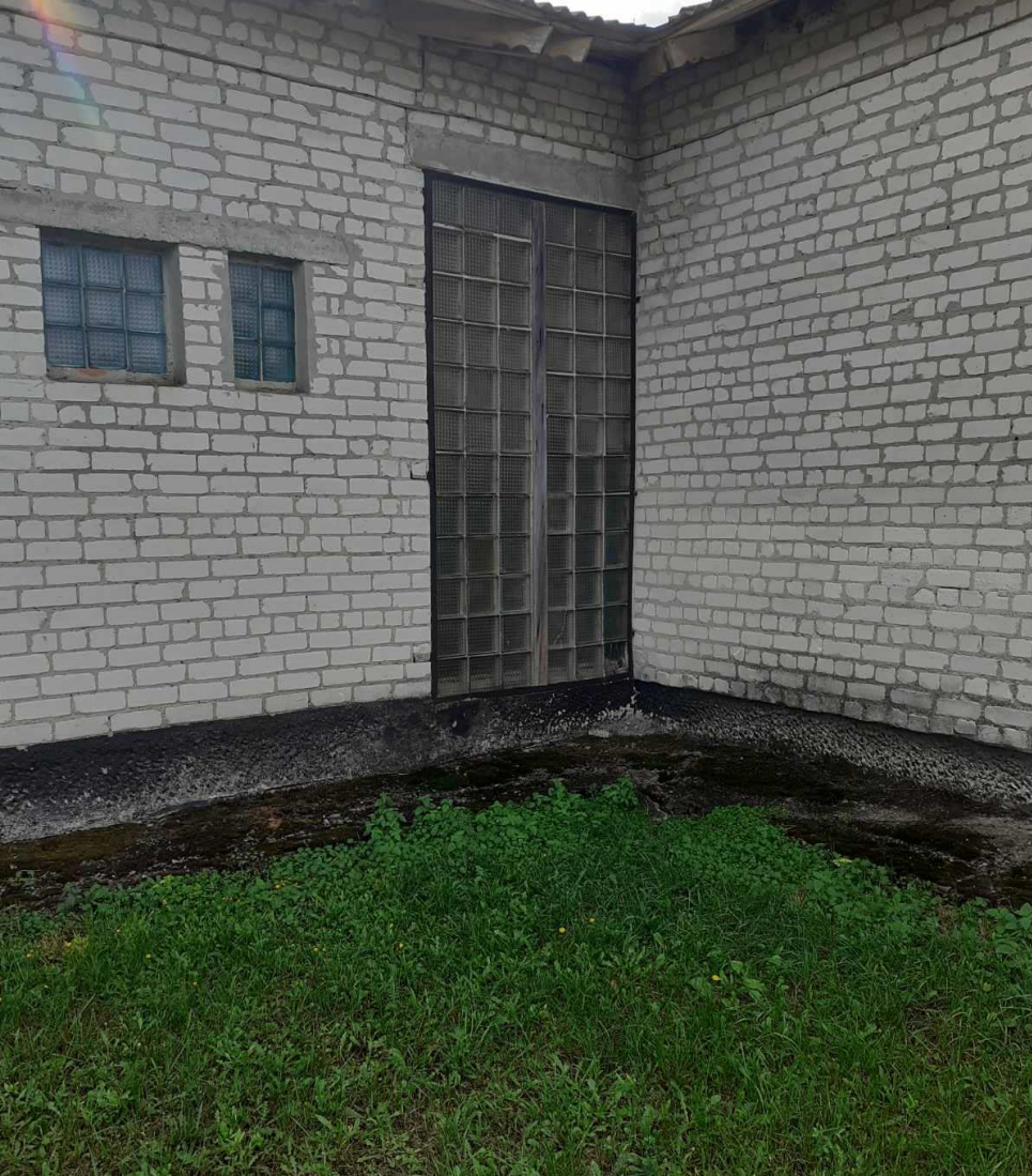
Встановлення входних дверей та облаштування пандусу в будівлі центру для тимчасового проживання внутрішньо переміщених осіб в с.Паліївка
